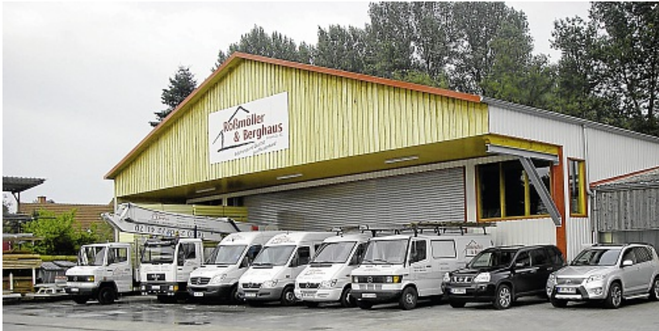
Anhand der neuen Halle, die in Holz-Rahmenbauweise erstellt wurde, kann auch die Leistungsfähigkeit des Handwerksbetriebs abgelesen werden. Foto: Privat
