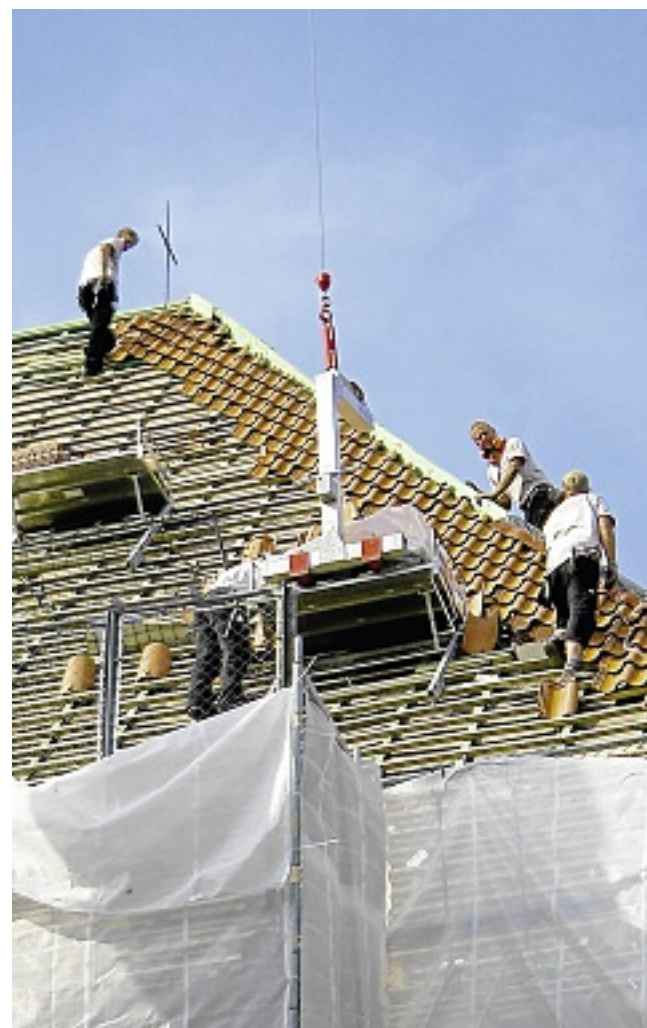
Im kompletten Münsterland sind die Mitarbeiter von Roßmüller und Berghaus im Einsatz. Zu den aktuellen Baustellen gehört auch die Nottulner Pfarrkirche. Foto: privat
