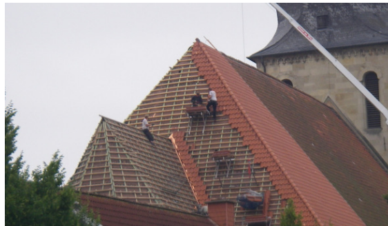
Mit der Sanierung vom Dach der St. Martinus Kirche in Nottuln stand in diesem Jahr ein großes Projekt an.
